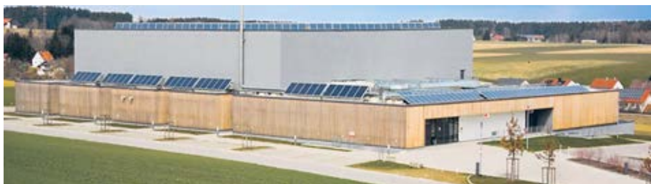
Ballsporthalle Vilsbiburg mit beispielhaftem Energiekonzept.
